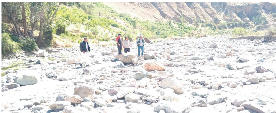
FOTOGRAFIA 02: Tramo crítico en la margen derecha del río San Juan, sector Quilcay Amaylla, donde se ejecutará limpieza, descolmatación, conformación de dique y enrocado en una longitud de 1,500 m., a fin de proteger esta margen de la acción erosiva del río San Juan.
